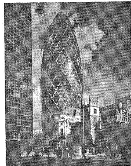
Konstrukce budovy je v pohybu, každé patro je pootočeno o jednu dvouasedmdesátinu délky obvodu. Vedle vnějšího estetického výrazu to má i kladný přínos z hlediska vytváření vnitřního prostoru šachty s relaxačními terasami. Zvyšuje se kontakt lidí mezi jednotlivými patry a zároveň je zachovaná i jistá intimita. Terasy jsou otevřené do volného prostoru, naproti tomu kanceláře jsou od prosklené fasády odděleny vlastní skleněnou stěnou.
