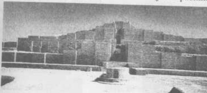
Obr. 1.3 Velký zigurat Choga Zanbil, délka půdorysné strany 67 m, cihly 350x150x100 mm
