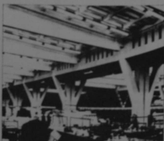
Fezko Strakonice Konstr. 1-podl. haly se skříňovými průvlakem
